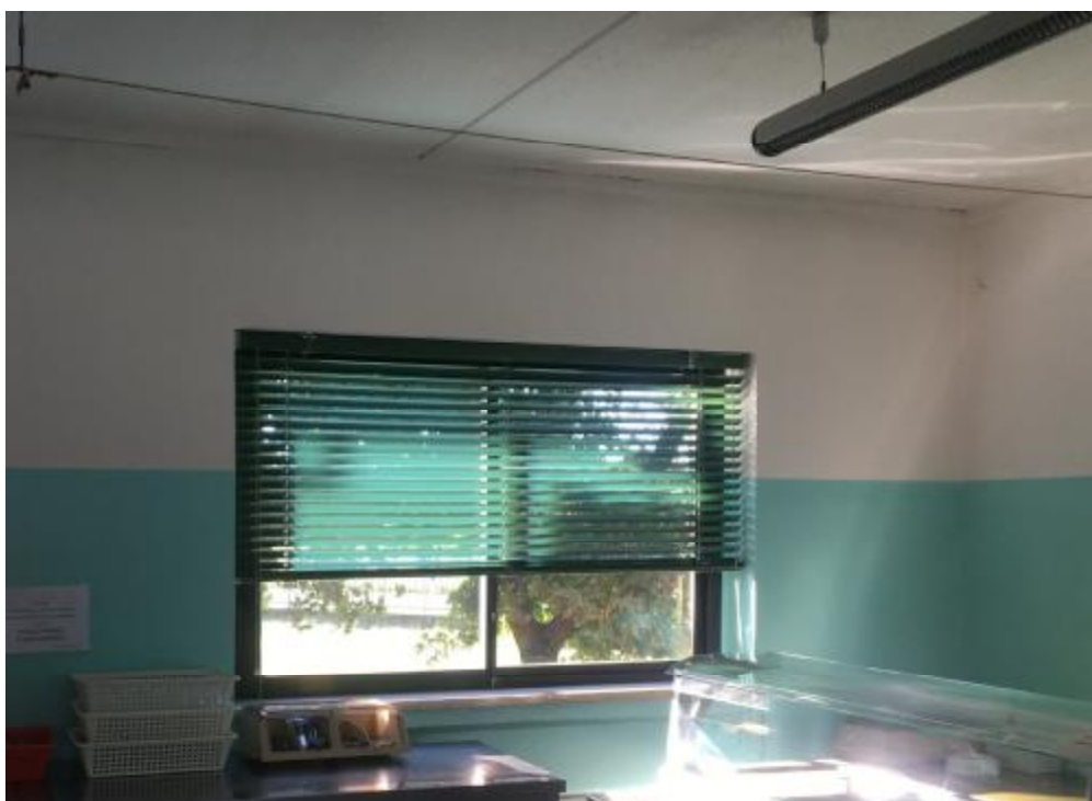
Foto n. 04. Interno – piano terra
