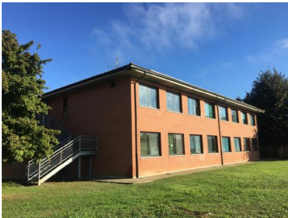
Foto n. 02. Esterno – fronte sud
