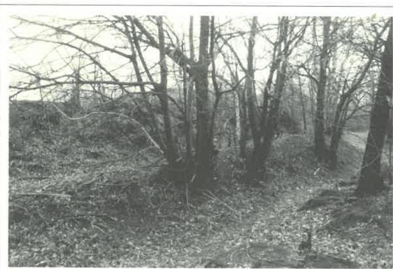
Il mucchio di terra di riporto allo stato di inizio dei lavori
