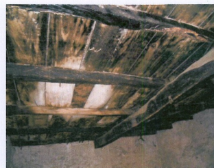
Solaio in legno dela cellia in esame.
