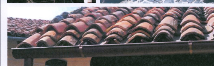
Le coperture: si possono notare bene l'orditura alla piemontese e il manto in tegole. Queste posizionate in modo spesso irregolare, probabilmente aggiunte nel tempo per evitare infiltrazioni d'acqua.
