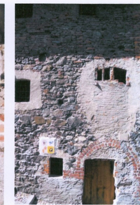
Tracce di intonaco sulla muratura del fronte est.
