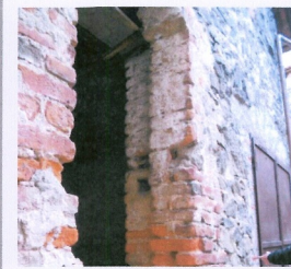
E' visibile la muratura portante in corrispondenza di una apertura sul fronte sud.
