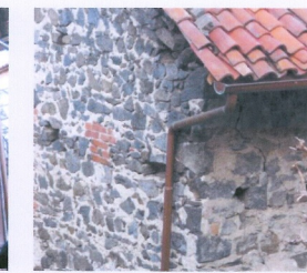
La soluzione dell'angolo è risolta utilizzando lo stesso materiale lapideo.
