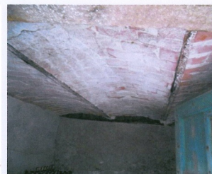
Le voltine in muratura con travi in ferro.
