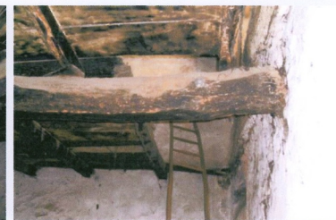
Particolare di una delle travi portanti. Si può notare come questa vada a incastrarsi all'interno della muratura.
