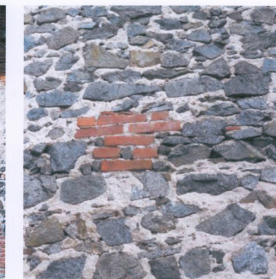
Particolare della texture muraria. Oltre alle pietre sono presenti, talvolta, tamponamenti di mattoni rossi, usati anche per definire le aperture.
